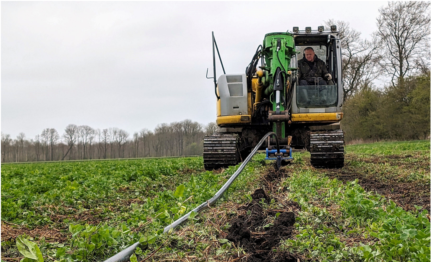
De 22 kilometer jordvarmeslanger er allerede lagt ned i 1 meters dybde i markerne ved Det Grønne Museum. På billedet ses en medarbejder ved jordvarmeslanger.dk i arbejde.
